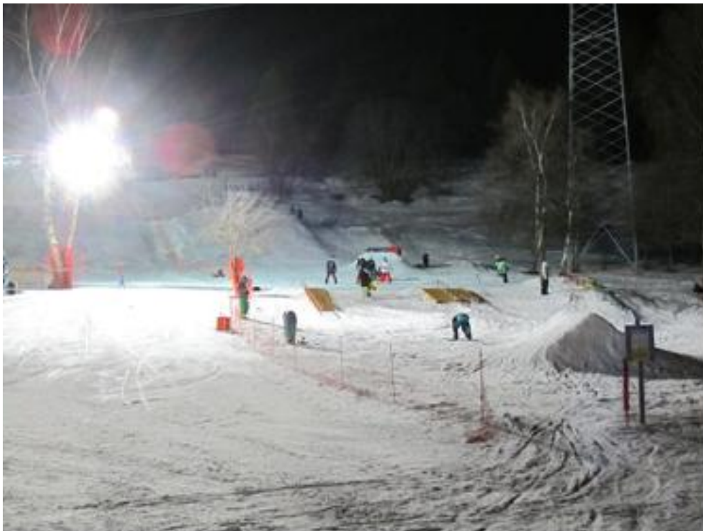
Abbildung 2: Pistenbeleuchtung in Tulfes/Tirol. Ein weiteres Beispiel für eine sehr stark abstrahlende Pistenbeleuchtung. Mit Full-Cut-Off-Leuchten wäre die Beleuchtung optimierbar.
