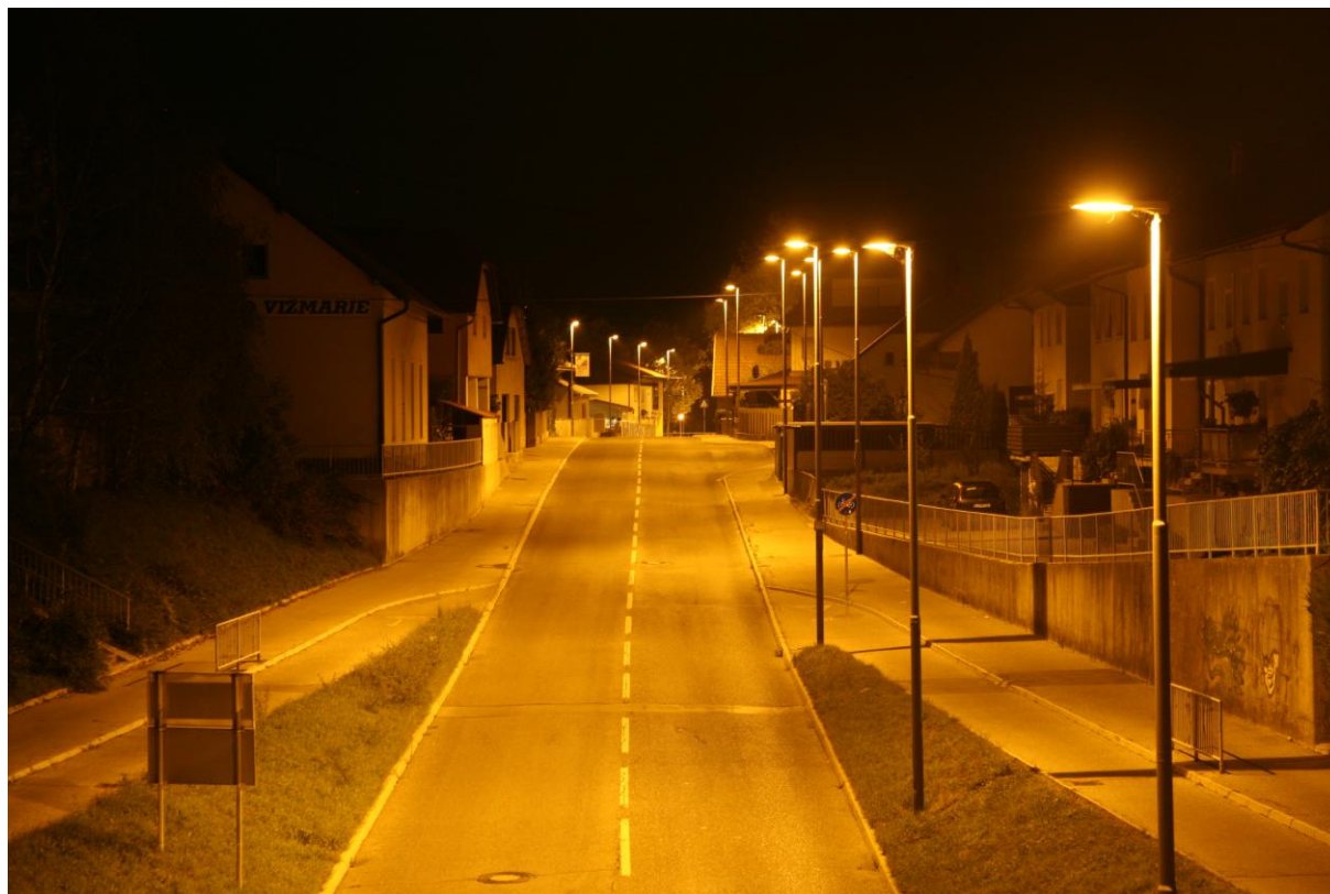
Abbildung 1: Straße in Vižmarje, Ljubljana. die Aufnahme stammt aus dem Jahr 2012 nach der Erneuerung der Straßenbeleuchtung, bei der entsprechend der neuen Verordnung die Hälfte der Leuchtmasten ersetzt und nur flache Abstrahler nach unten verwendet wurden.
