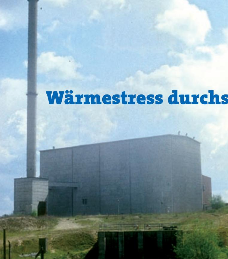
Ein „gewässerökologisches Großexperiment mit unsicherem Ausgang“ nennt es der Wissenschaftler Peter Kasprzak: Etwa 300 Millionen Liter Kühlwasser aus dem Kernkraftwerk Rheinsberg, zehn Grad wärmer als das Seewasser, strömten in den Stechlinsee – täglich und das über 20 Jahre lang.
