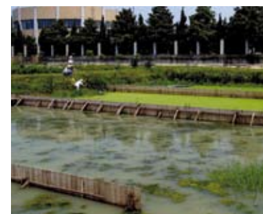
Abb. 3 Teichanlage zur Reinigung des Seewassers für die Trinkwasseraufbereitung (Foto: S. Pflugmacher)
