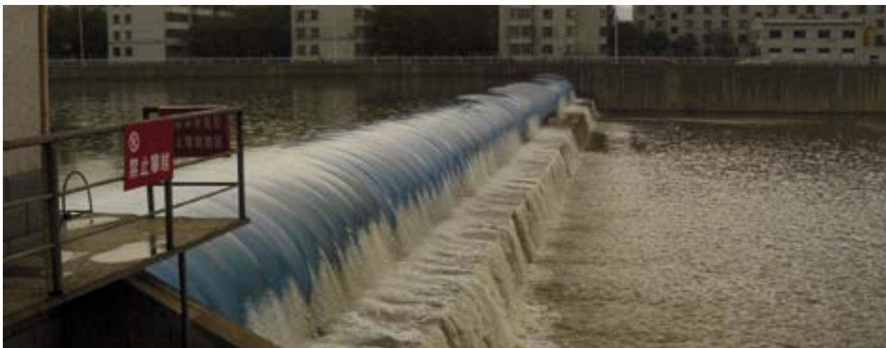
Der Qingshui Fluss kurz vor der Einmündung in die Stadt Zhangjiakou (Provinz Hebei, China). Das Flussbett ist komplett als Kastenprofil betoniert. Das Wasser wird in der Stadt durch eine Kaskade von mehr als 15 Barrieren aus blauem Kunststoff («rubber dams») zu einem «künstlichen» Fluss gestaut und gewährt den Einwohnern den Anblick eines breiten Flusses. Unterhalb der Stadt ist der Qingshui infolge von Wasserentnahme (Landwirtschaft, Kühlwasser für Kraftwerke etc.) wieder ein Rinnsal.
