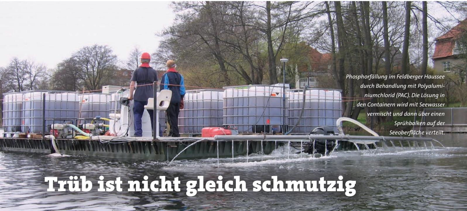
*Phosphorfällung im Feldberger Haussee durch Behandlung mit Polyaluminiumchlorid (PAC). Die Lösung in den Containern wird mit Seewasser vermischt und dann über einen Sprühbalken auf der Seeoberfläche verteilt.*
