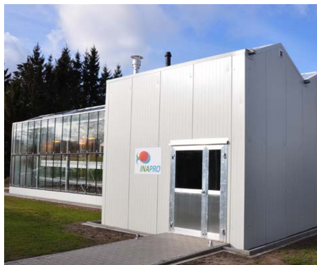
INAPRO-Forschungsanlage mit Fischhalle, Technikraum und Gewächshaus.
